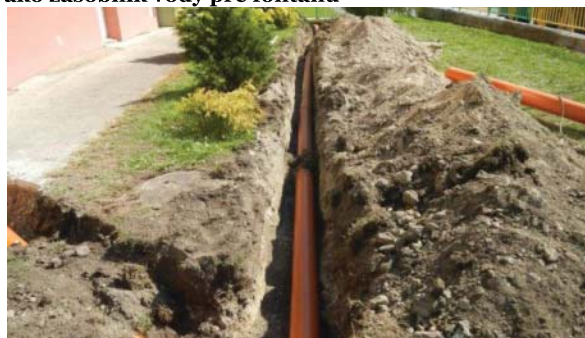
Obr. 32: Vedenie zrážkovej vody do nádrže, ktorá slúži ako zásobník vody pre fontánu
