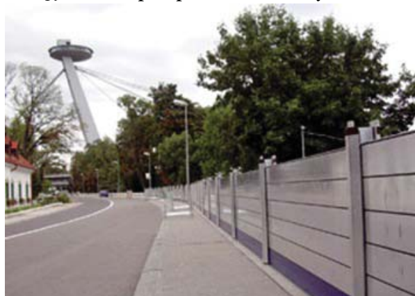
Obr. 59: Mobilné protipovodňové zábrany v Bratislave
