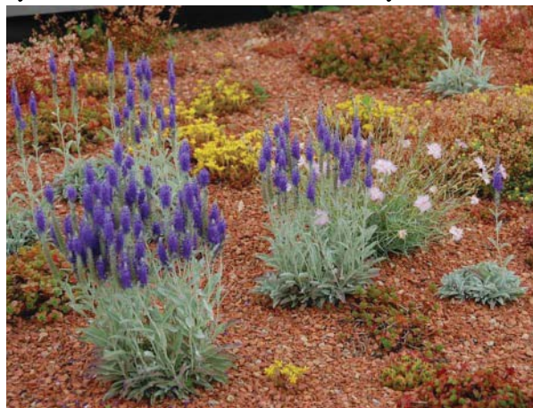
Obr. 42: Extenzívna vegetačná strecha tvorená výsadbou rozchodníkov a suchovzdorných trvaliek
