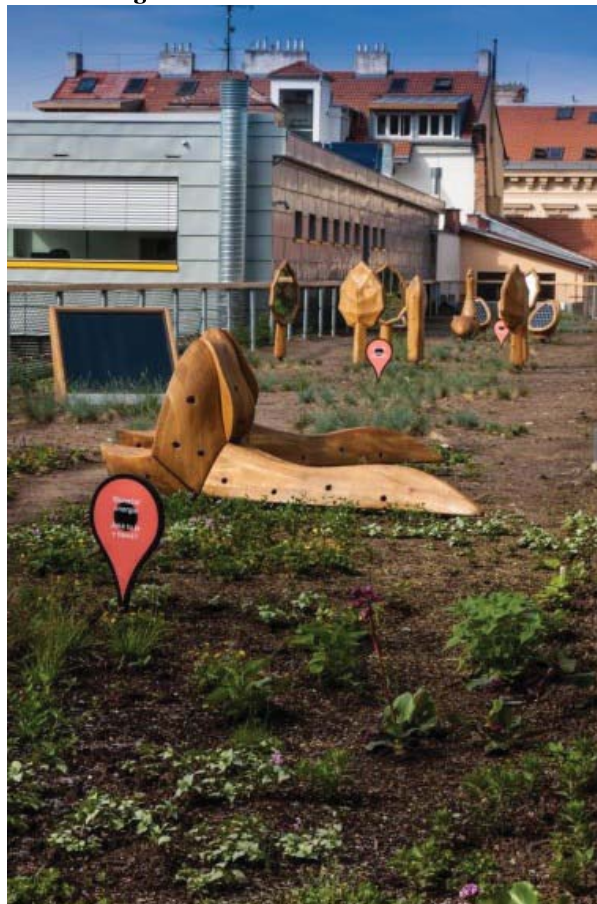
Obr. 80: Vegetačná strecha na budove C
