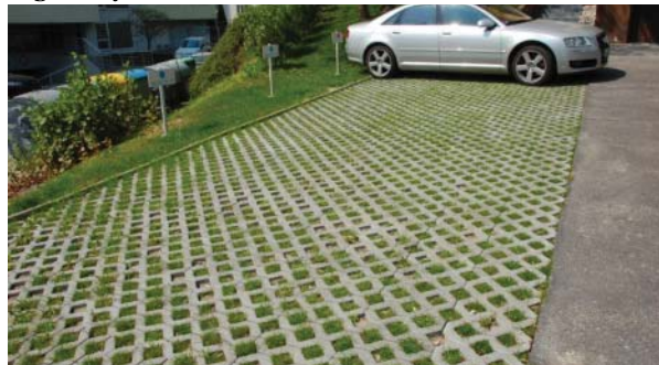
Obr. 9: Parkovisko v Bratislave z betónových vegetačných tvárnic
