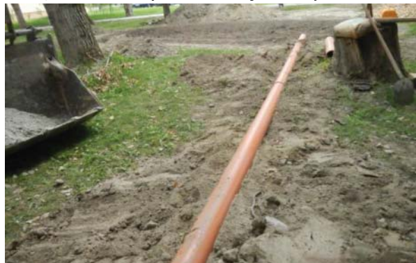
Obr. 71: Prívod vody do dažďovej záhrady
