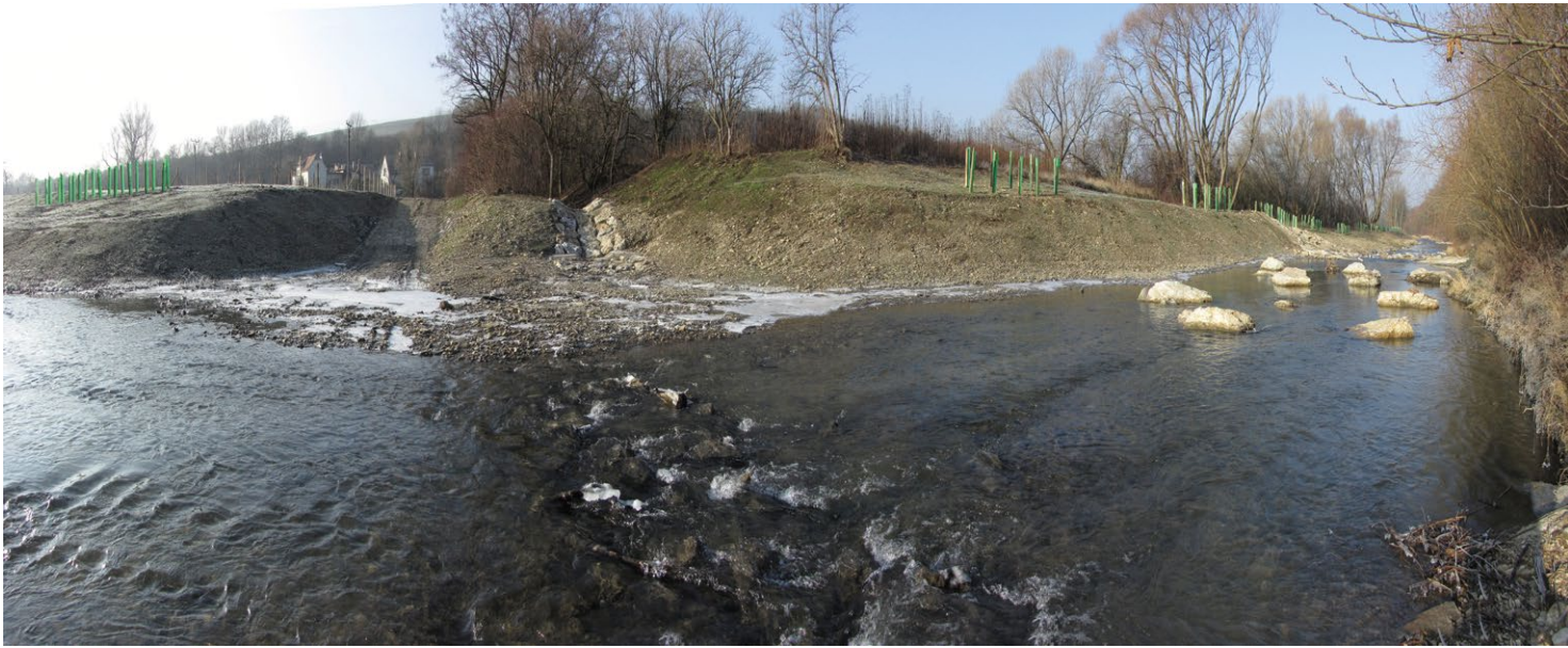
Stav Veličky po realizaci opatření — Zdroj: Povodí Moravy
