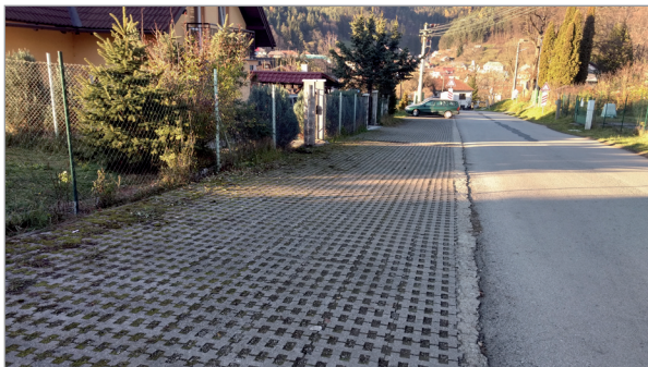
Využitie zatrávňovacej dlažby na ploche parkoviska
