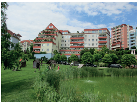
Foto č. 50, 51: Banská Bystrica časť Belveder
