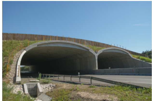
Obr. 7.6 Jedním z cílů protokolu o udržitelné dopravě je minimalizace negativního vlivu dopravy na životní prostředí. Zelený most Moravský Svätý Ján na slovenské dálnici D2 byl postaven za účelem obnovení migrace živočichů v rámci Alpsko-karpatského koridoru, který byl přerušen frekventovanými silnicemi a zástavbou mezi Alpským a Karpatským pohořím. © Dušan Valachovič
