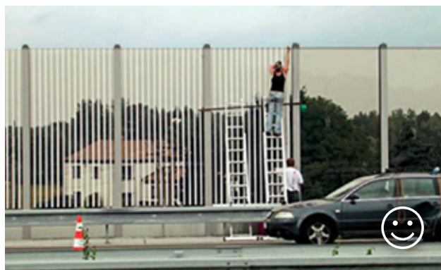
Obr. 10.60 Instalace svislých pruhů nalepením na protihlukové stěny na dálnici D47 v České republice. V roce 2008 bylo na úseku pouhého 1 km této dálnice mezi Bohumínem a Ostravou nalezeno téměř 200 mrtvých ptáků během 6 měsíců. Po instalaci svislých pruhů klesla mortalita prakticky na nulu. © Jan Mayer
