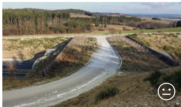
Obr. 10.29 Hlavní funkcí tohoto víceúčelového nadchodu s místní komunikací je umožnění pohybu volně žijících živočichů. Odpovídající úpravy jsou vhodné pro pohyb malých a středně velkých savců. Velcí savci však takovýto nadchod nevyužijí. Víceúčelové nadchody jsou tedy zcela nežádoucí v místech, kde dopravní infrastruktura kříží dálkový migrační koridor. Písek, Česká republika. © Václav Hlaváč
