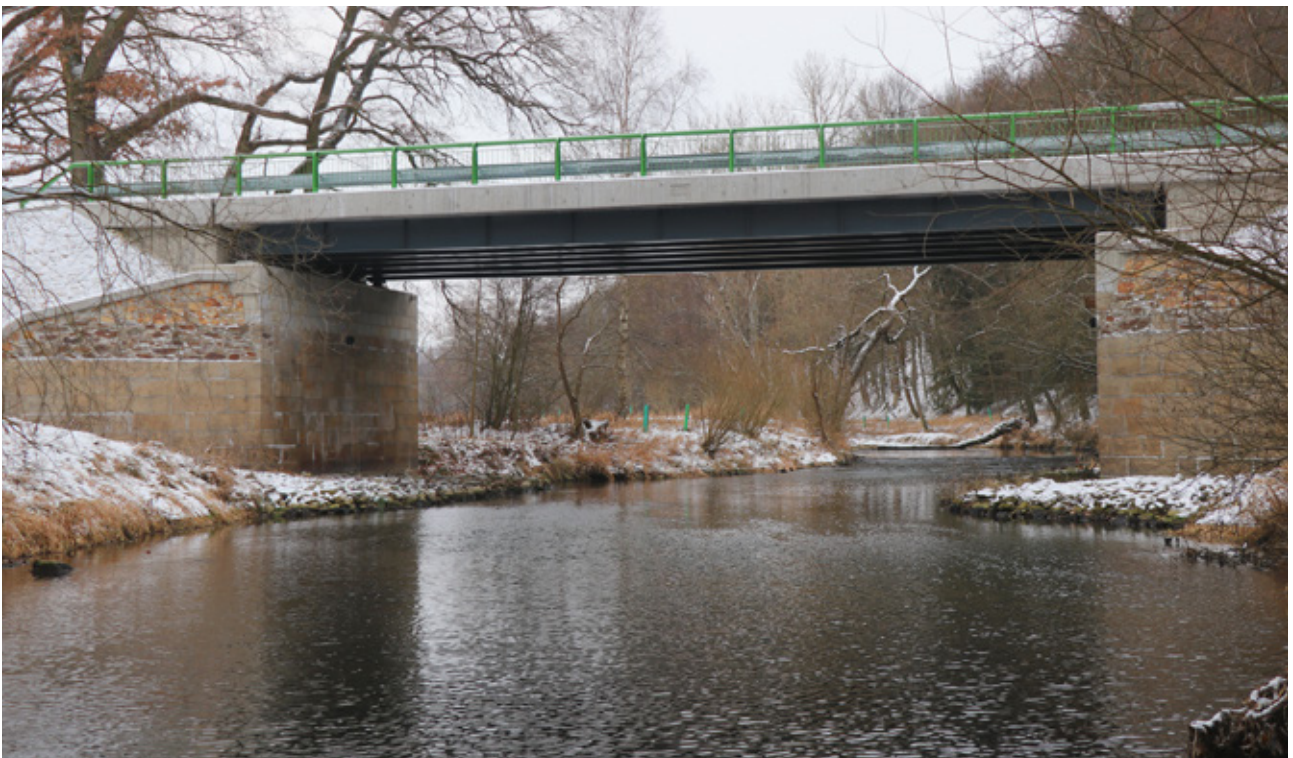
Obř. 10.1 Mosty přes vodoteče mohou být snadno upraveny tak, aby živočichům umožnily bezpečný průchod pod komunikací. Je nezbytné zachovat přirozené břehy pro návaznost terénu. © Václav Hlaváč
