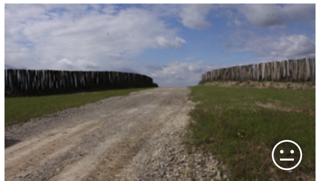
Obr. 10.32 Takovýto víceúčelový nadchod má pro volně žijící živočichy pouze omezené využití. Chybí zde úkryty a mikrobiotopy pro malé druhy a keře pro větší druhy. Potřeba úkrytů je o to vyšší, že zvěř nevidí bezpečnou krajinu na druhé straně nadchodu.
