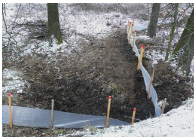
Obr. 10.57 Instalace dočasných zábran během jarní migrace může zabránit vstupu obojživelníků na komunikaci a zároveň je nasměrovat k bezpečnému podchodu. Po období migrace musí být zábrany odstraněny. © Jaromír Maštera
