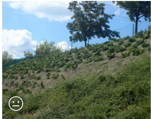
Obr. 9.21 Výsadba vegetace se často provádí za účelem stabilizace svahu. Keřový a stromový pokryv však může vytvářet atraktivní stanoviště pro řadu živočišných druhů včetně velkých savců. Je-li vegetace vysazena do prostoru mezi plotem a vozovkou, může zvířata svádět ke vstupu do nebezpečného oploceného prostoru. © archiv NDS
