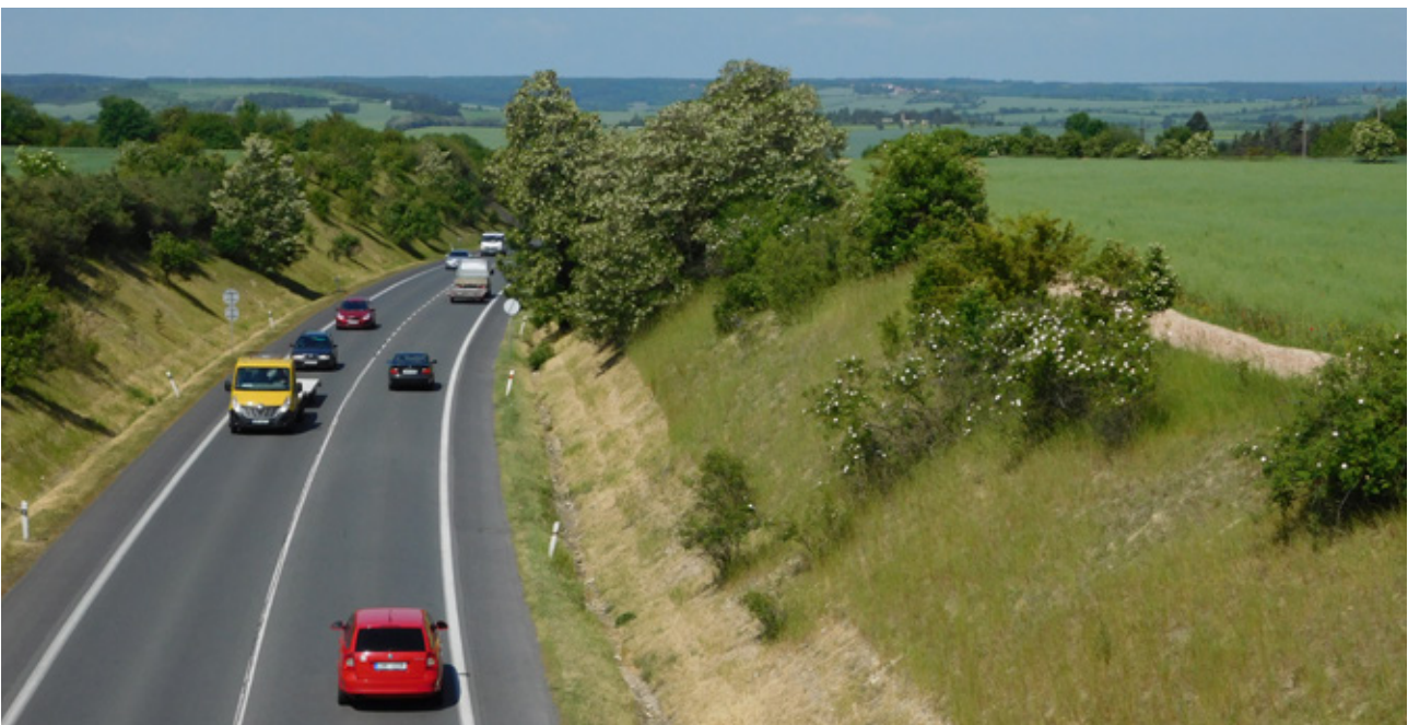
Obr. 4.9 Vhodně udržované krajnice představují vhodné stanoviště pro bezobratlé a plazy. © Klára Řehouňková
