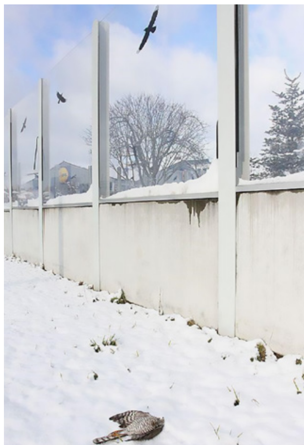
Obr. 6.43 Průhledné stěny podél silnic ve městech jsou častou příčinou vysoké úmrtnosti ptáků. Dříve používané siluety dravců nejsou účinnou ochranou, je proto nutné uplatňovat řešení, která ptákům umožní včas bariéru zaznamenat. © Václav Hlaváč
