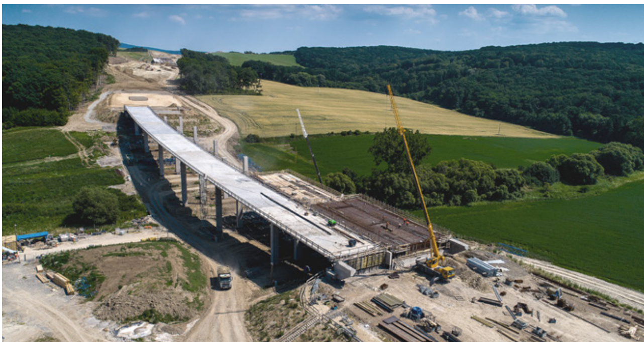
Obr. 5.10 Socioekonomické změny po roce 1989 přinesly extrémně rychlý růst intenzit provozu, což podnítilo zvýšené stavební úsilí. Další rozvoj dálnic se očekává v nejbližších letech. © archiv NDS
