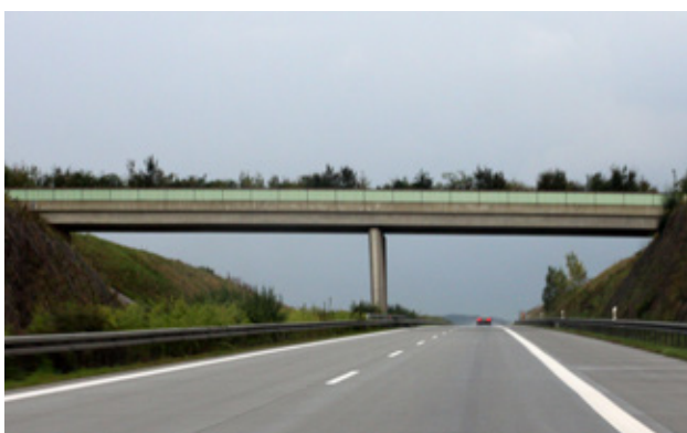
Obr. 10.18 Lesní cesta nad dálnicí rozšířená o pásy keřů slouží jako průchod pro malé druhy netopýrů a zároveň může být využívána širokým spektrem jiných druhů živočichů. Německo. © Václav Hlaváč
