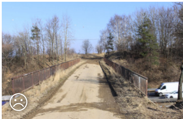
Obr. 10.10 Mosty převádějící polní a lesní cesty, které jsou pokryté betonem či asfaltem, nejsou zvěří využívány. Nadchody se zelenými pásy po obou stranách někdy využívá zajíc, kuna skalní nebo liška. Rušivý vliv dopravy způsobený hlukem je v případě dálnic pro většinu živočichů limitujícím faktorem. © Václav Hlaváč
