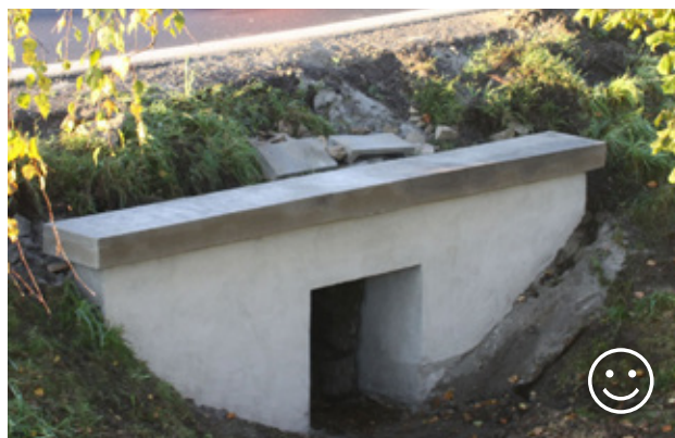
Obr. 10.4 Nejčastějším cílovým druhem při řešení migrace obojživelníků přes komunikace je ropucha obecná. Trubní propustky jsou pro tento druh přijatelné pouze v případě, kdy je uvnitř dostatek světla a dno je pokryto nánosy. Více informací na toto téma v kapitole 10.3.2.4. © Jaromír Maštera
