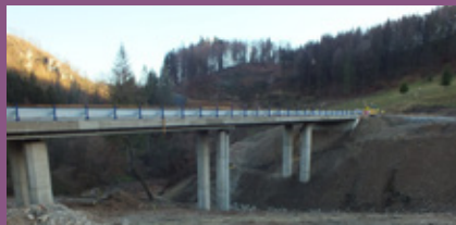
B) Výstavba nového mostu na pilířích – koridor je částečně funkční. Je ještě nutné vysadit naváděcí vegetaci pod mostem a v jeho okolí. © Drahoš Blanár
