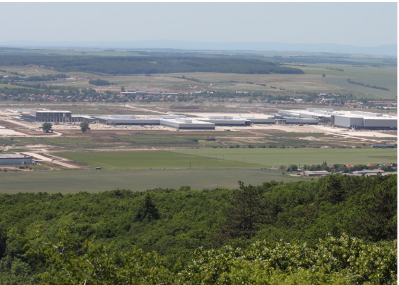
Obr. 4.11 Nová dopravní infrastruktura často přináší do dané oblasti další výstavbu. Logistické centrum nedaleko města Nitra. © Michal Ambros
