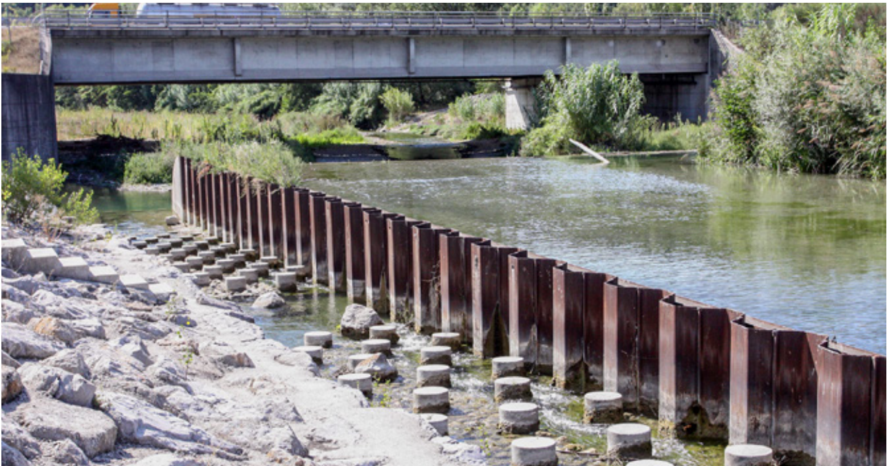
Obr. 10.50 Rybí přechod poblíž Lyonu ve Francii, kde na vodním toku vznikl v důsledku vybudování silniční komunikace výškový stupeň. Rybí přechod je vybudován přímo na vodním toku a je využíván všemi druhy ryb, které se zde vyskytují. Pro průchod ho též využívá vydra. © Václav Hlaváč
