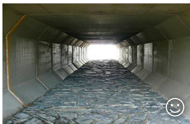
Obr. 10.5 V porovnání s trubním propustkem je pro migraci obojživelníků rámový propustek vždy lepším řešením. Povrch podchodu je pro tyto živočichy velmi důležitý, přičemž kamenná dlažba je vhodnou volbou. © Václav Hlaváč
