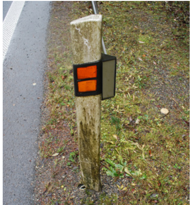
Obr. 12.19 Průmyslově vyráběný odpuzovač zvěře montovaný na silniční patník. Reflexní prvek odráží světlo od blížícího se auta ke straně silnice a tím varuje zvířata. Pokles úmrtnosti živočichů v důsledku instalace těchto světelných odrazujících prostředků nebyl dosud uspokojivě potvrzen. Beskydy, Česká republika. © Martin Strnad
