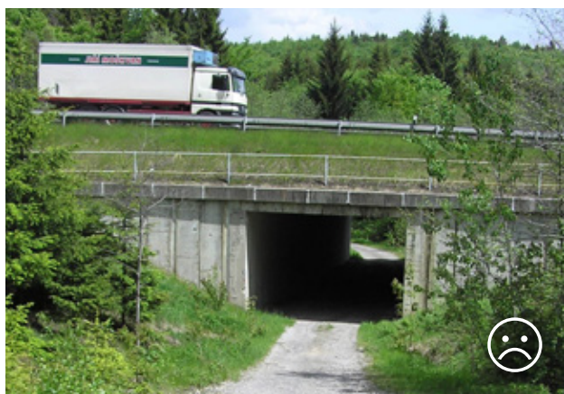
Obr. 10.40 Tento podchod s lesní cestou není vhodný pro průchod volně žijících živočichů. Jeho rozměry ( \bar{s} = 6 m, v = 5 m, d = 33 m, tzn. IO = 0,9 ) jsou pro velké savce nevhodné. Středně velcí savci, jako srnec obecný a prase divoké, využijí takový podchod pouze v případě, jsou-li eliminovány rušivé vlivy (tzn. instalace protihlukové stěny podél komunikace a omezená lidská činnost). Česká republika, dálnice D1. © Václav Hlaváč
