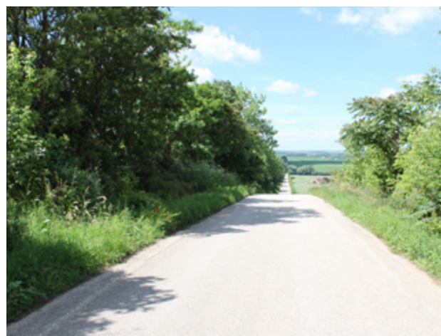
Obr. 9.23 Silniční okraje se vzrostlou vegetací jsou méně přehledné pro řidiče i zvířata, což zvyšuje riziko nehod. © Michal Ambros
