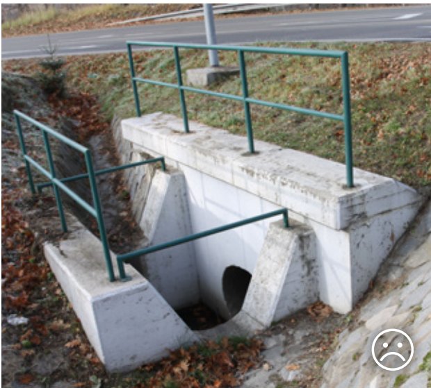
Obr. 10.6 Sedimentační jímky na vpusti nebo výpusti zamezují migraci obojživelníků skrz tyto objekty. Takováto technická řešení navíc mohou představovat pasti bez možnosti úniku, kde umírají desítky obojživelníků. © Václav Hlaváč
