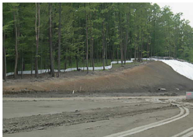
Obr. 8.6 Dočasné bariéry slouží k zamezení vstupu obojživelníků na staveniště. Živočichové by v takových případech měli být směrováni k vhodným průchodům nebo odchycení a přemístění do vhodného prostředí. © NaturaServís s r.o.
