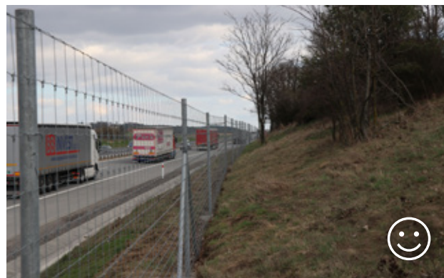
Obr. 10.53 Vhodné umístění oplocení. Stromy a keře představují atraktivní biotop pro široké spektrum druhů a měly by tedy zůstat mimo oplocenou oblast. Kontrola funkčnosti takto umístěného oplocení je zároveň jednodušší než u oplocení umístěného až na hraně zářezu či náspu. © Václav Hlaváč
