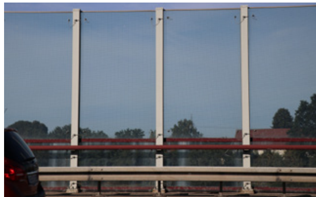
Obr. 10.61 Svislé pruhy nebo drátěná síť přímo ve stěně spolehlivě chrání ptáky před nárazy a zároveň představují přijatelná řešení z hlediska architektury. © Václav Hlaváč
