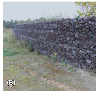
Obr. 10.28 Protihlukové stěny efektivně omezují rušivé vlivy na zelených mostech. Mohou být vybudovány ze dřeva (A), plastu, nebo jako kamenné stěny (B). Kamenné stěny jsou nákladnější a představují vyšší zátěž na most, avšak vytvářejí nové biotopy (např. pro plazy) a jejich životnost je prakticky neomezená. © Václav Hlaváč
