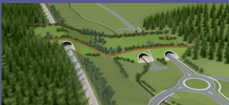
Vizualizace návrhu zeleného mostu u obce Svrčinovec (šířka 80 m), který byl vybrán k další diskusi s příslušnými zájmovými skupinami. © archiv NDS
