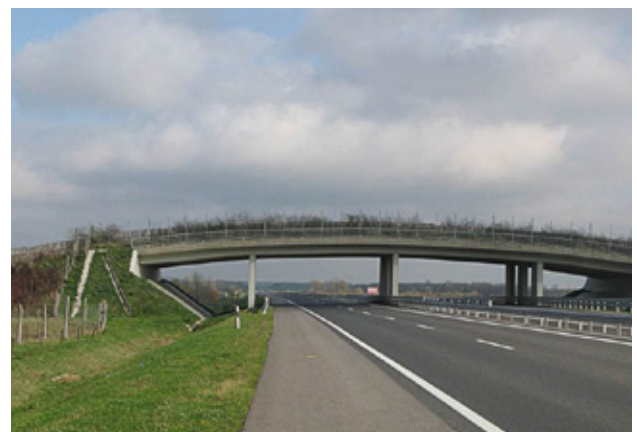
Obr. 6.42 Zelený most lze vybudovat i v rovinaté krajině, kde dálnice vede ve stejné úrovni s terénem. Spojení mostu s okolním terénem však zabírá větší plochu než v případě dálnice vedoucí v zářezu. Dálnice M7, Maďarsko. © Ábrahám László
