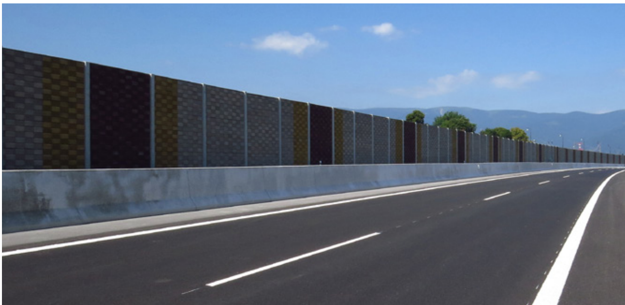
Obr. 4.8 Protihluková stěna eliminuje vliv rušení, zároveň ale zvyšuje bariérový efekt. © Tomáš Flajs
