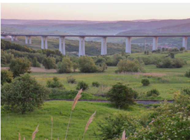
Obr. 9.8 Viadukty jsou k překonání údolí zpravidla vhodnější než náspy, protože umožňují volný pohyb živočichů a částečné zachování konektivity krajiny. Viadukt Aciliu na dálnici A1 (Bukurešť–Nadlac) v Rumunsku, župa Sibiu. © Tibor Sos
