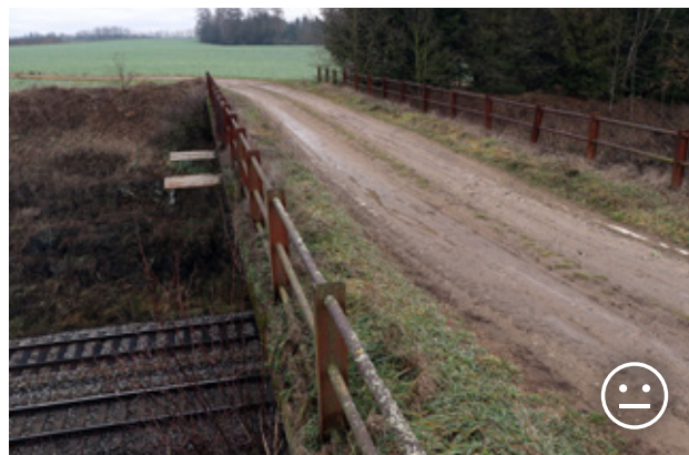
Obr. 10.2 Víceúčelový nadchod přes dvojkolejnou trať Praha-Brno (Česká republika) o šířce 7 m a délce 35 m. Travnaté pruhy po stranách nadchodu jsou využívány širokým spektrem bezobratlých živočichů. Díky hliněnému povrchu funguje nadchod jako průchod pro srnce, zajíce, lišku a mnoho dalších druhů menších obratlovců, včetně ještěrky obecné. Podobné mosty přes dálnice jsou využívány jen výjimečně, jelikož rušivé vlivy způsobené dopravou jsou zde mnohonásobně vyšší než u železnice. © Václav Hlaváč
