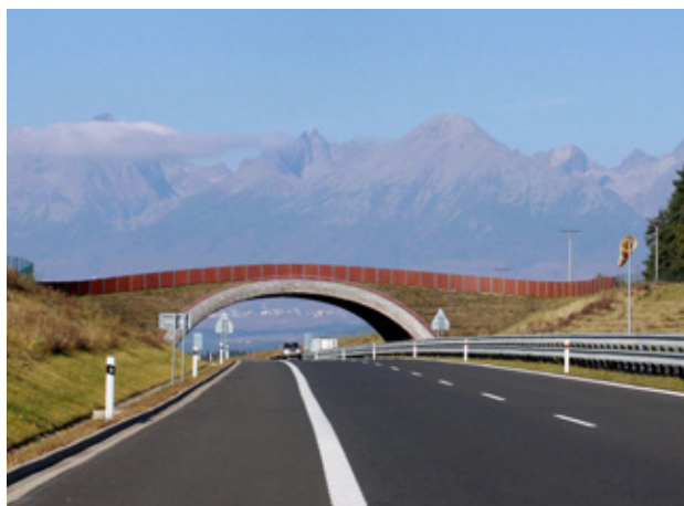
Obr. 1.2 Průchody pro živočichy jsou příkladem opatření, jejichž cílem je minimalizovat negativní dopady dopravy na volně žijící živočichy. © Václav Hlaváč
