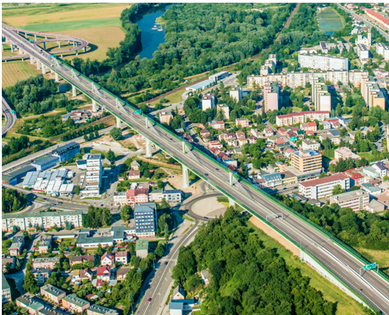
Obr. 9.11 Výstavba dálnice může narušit konektivitu zelených ploch také ve městech. Zajištění této konektivité je důležité pro řadu malých druhů živočichů. Dálnice D1 v Považské Bystrici, Slovensko. © archiv NDS
