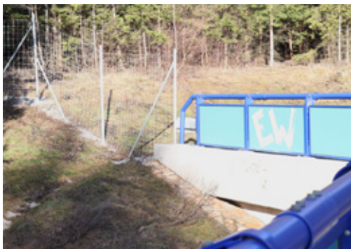
Obr. 10.27 Oplocení plynule napojené na ochranné stěny (zábradlí s výplní) slouží k navádění zvěře pohybující se podél dálnice ke vstupu na zelený most. Dálnice D1, Česká republika. © Václav Hlaváč
