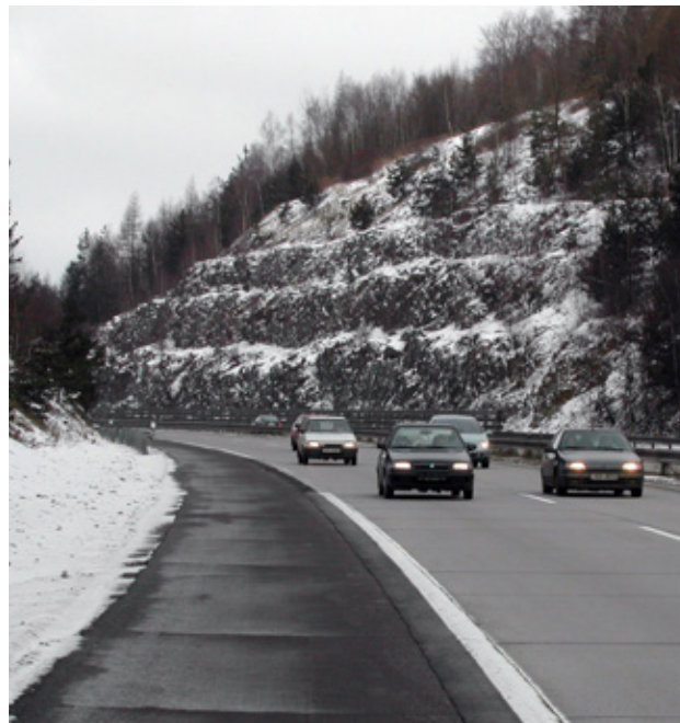
Obr. 9.12 Terasování stabilizuje svahy hlubokých zářezů a vytváří mikrostanoviště pro různé druhy rostlin a živočichů. © Václav Hlaváč
