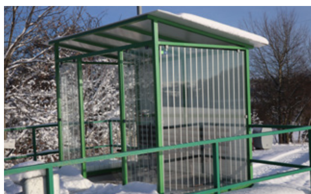
Obr. 10.62 Vysokou mortalitu ptáků můžeme zaregistrovat nejen u průhledných protihlukových stěn, ale též u autobusových zastávek. Zabezpečení proti nárazům je v obou případech obdobné (první autobusová zastávka shora byla upravena místními školáky, kteří u ní již nechtěli nacházet další mrtvé ptáky). © Petra Hulvová
