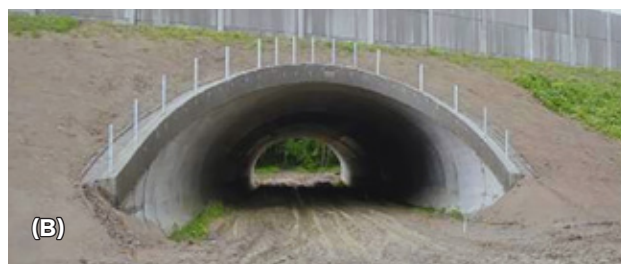
Obr. 10.37 Chování živočichů v blízkosti podchodu jasně poukazuje na fakt, že vnímají hluk způsobený projíždějícími vozidly (uložení mostní konstrukce) (A). Při výstavbě nových mostů je proto vždy nutné vybírat taková technická řešení, která minimalizují rušení hlukem v podmostí. Toho lze nejlépe docílit použitím vrstvy zeminy mezi mostní konstrukcí a samotnou komunikací (B). Ve srovnatelných podmínkách ale toto řešení bohužel vždy přináší redukcii rozměrů podmostí. © (A) Hnutí DUHA Olomouc, (B) AOPK ČR
