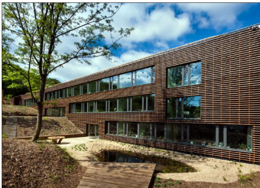
Kořenová čistírna efektivně čistí použitou vodu z umyvadel a zároveň v letních měsících výparem ochlazuje vzduch.
