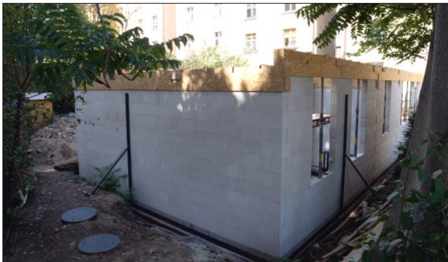
Dům je momentálně ve fázi výstavby – říjen 2015.
